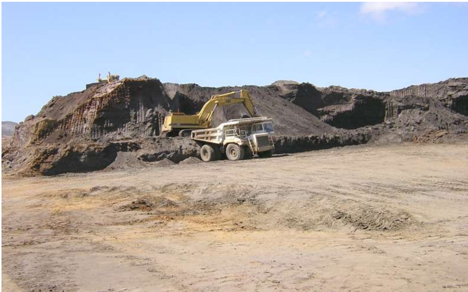
28-39-IN-FL-F 23.- Proyectos de rehabilitaci3n de las escombreras y vaciaderos de mina que tapizan el sector entre Llano del Beal y El Estrecho.
